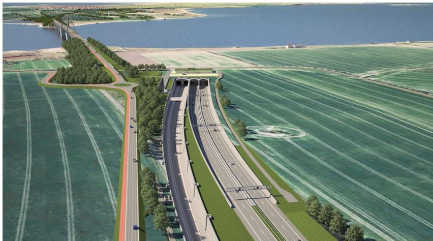
Die Fehmarnbeltquerung ist eines der größten europäischen Infrastrukturprojekte und verbindet künftig Deutschland und Dänemark durch einen 18 km langen Absenktunnel zwischen Puttgarden (DE) und Rødby (DK). Zur Anbindung des Tunnels an das deutsche Schienennetz erfolgt der Ausbau der Bahnstrecke zwischen Lübeck und Puttgarden.
